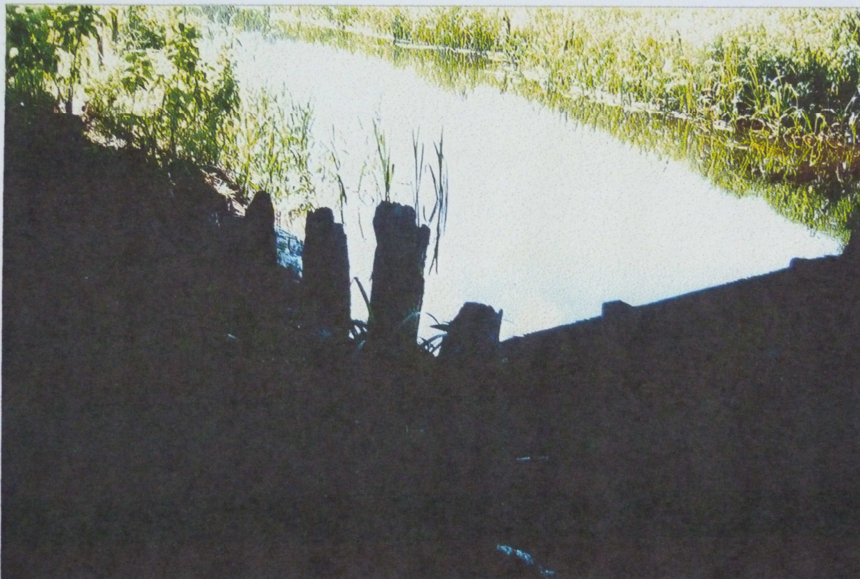
Foto.6. Widok koryta Potoku Zadębie pod mostem – widoczne pale nośne „starego” mostu.
