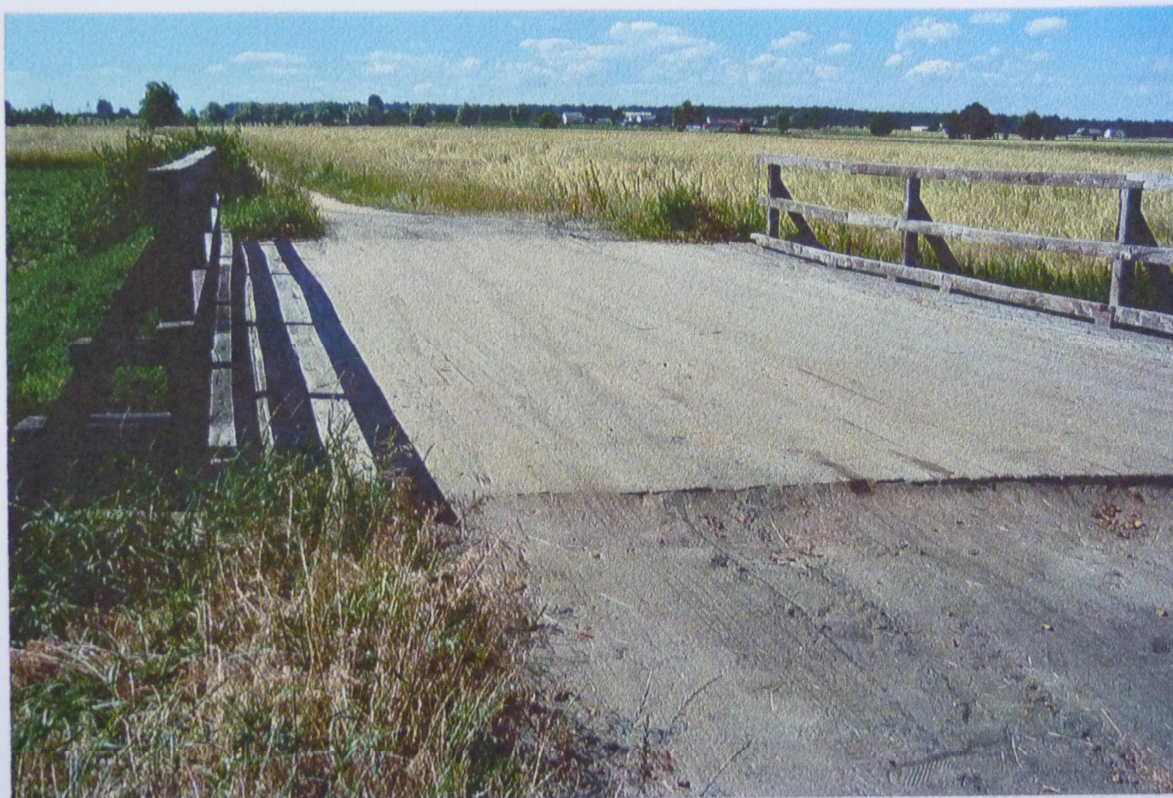
Foto.1. Widok ogólny mostu, drewniana konstrukcja jezdni i balustrady.
