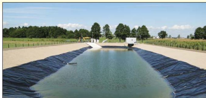
Faktyczna stawka opłat za 1 m 3 ścieków wzrosła w stosunku do ubiegłego roku o kwotę 0,20 zł netto (na zdjęciu fragment oczyszczalni ścieków w Uniecku)
