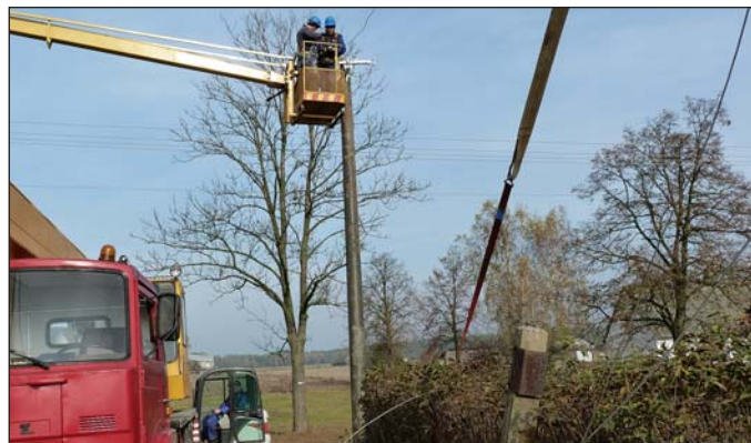
Udało się rozwiązać problem ze słupem elektrycznym w Koziebrodach, który blokował budowę drogi w kierunku Niedroża. Na zdjęciu stawienie słupa energetycznego w nowym miejscu
