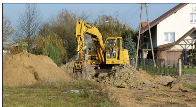
Budowa sieci kanalizacyjnej i wodociągowej w Koziebrodach
