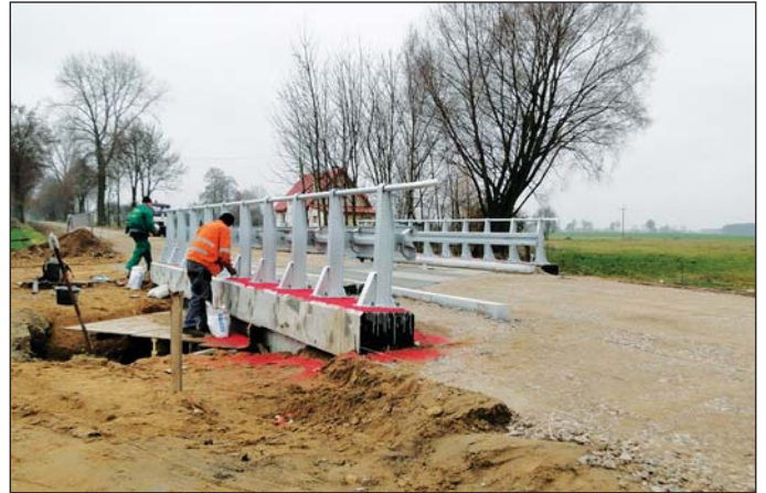
Ostatnie prace przy budowie mostu na Rokitnicy
