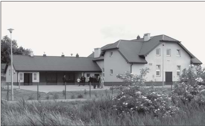
Oczyszczalnia ścieków w Gralewie została oddana do użytku w 2008 r.
