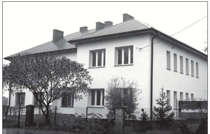
W 2008 r. zakończono modernizację budynku ośrodka zdrowia w Koziebrodach
