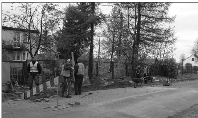
Na jezdni przy szkole w Kozybrodki powstało tzw. wyniesione przejście dla pieszych
