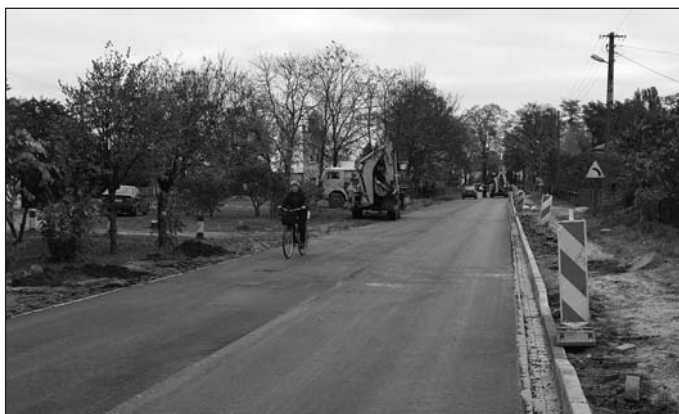
Wraz z modernizacją drogi powstają nowe chodniki
