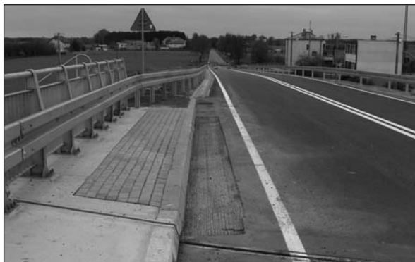
Chodnik jest tylko na niewielkim odcinku na samym szczycie wiaduktu, dalej chodnika i pobocza brak
